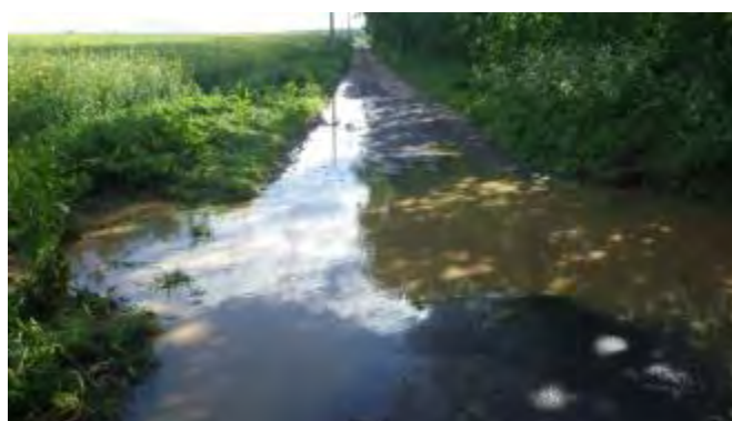
Photographie 6 : Inondation par traversée d'écoulement d'un talweg situé perpendiculairement à une voirie
